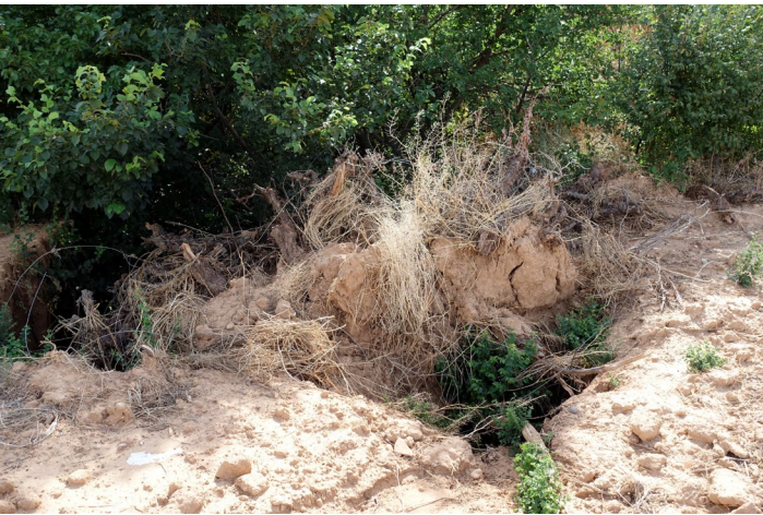
Procesos erosivos (adaptación)
